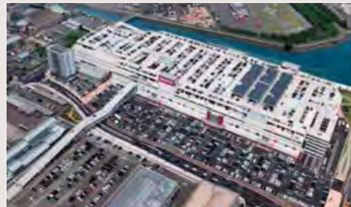
屋上に350kW発電パネルを約2,900㎡設置しました
